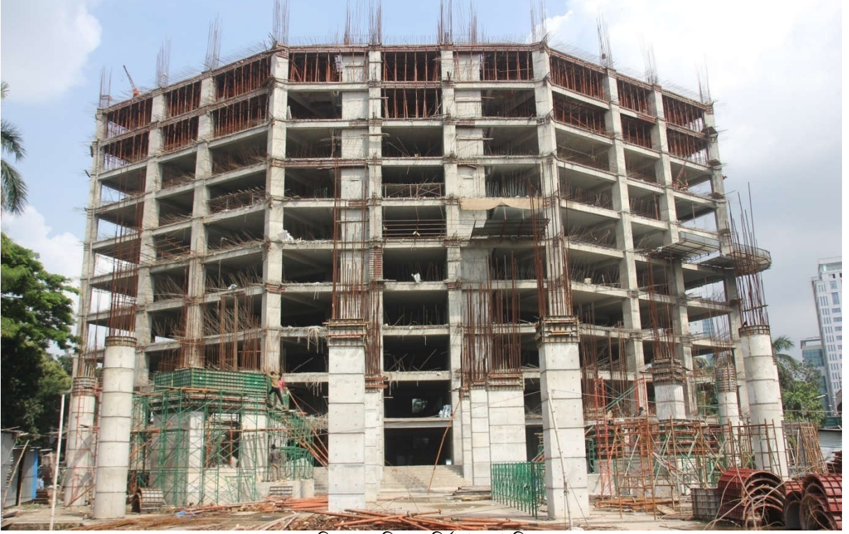
ছবি ৪.১০: ভূমি ভবন নির্মাণের অগ্রগতি
